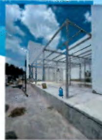
Adaptación de almacén en estacionamiento techado
