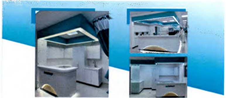
Suministro e instalación de centrales de enfermería del Hospital General de Zapopan
