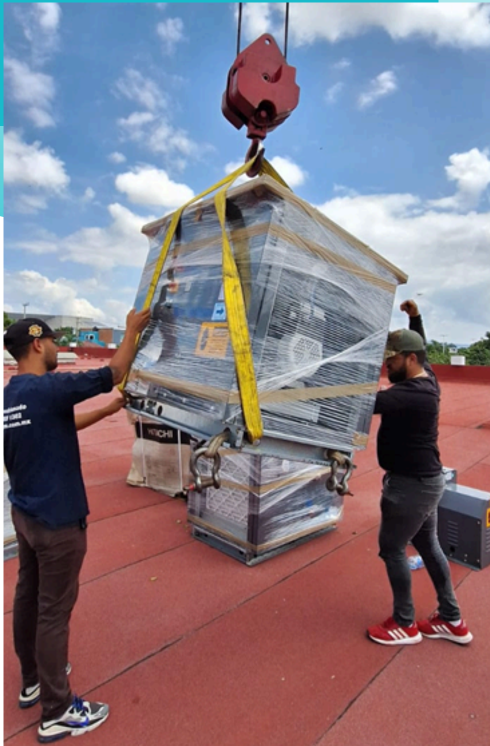
Suministro y colocacion de aire acondicionado para el quirofano del Hospital General de Zapopan.
