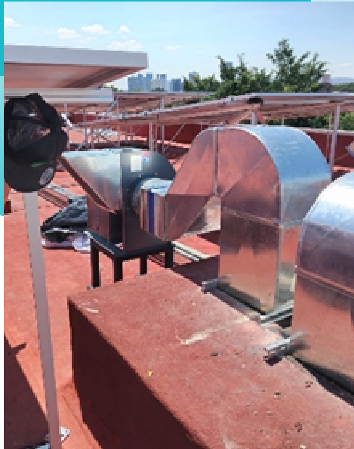
Suministro y colocacion de aire acondicionado para el quirofano del Hospital General de Zapopan.
