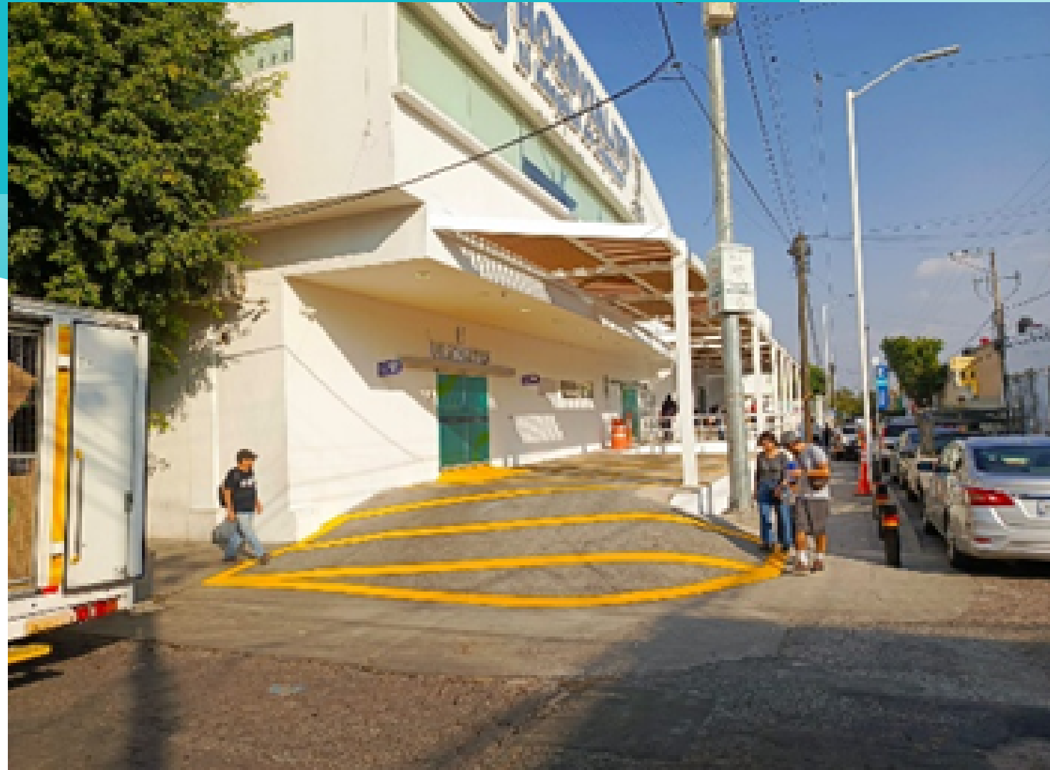
Cubierta apergolada de ingreso de ambulancia hasta entrada principal.
