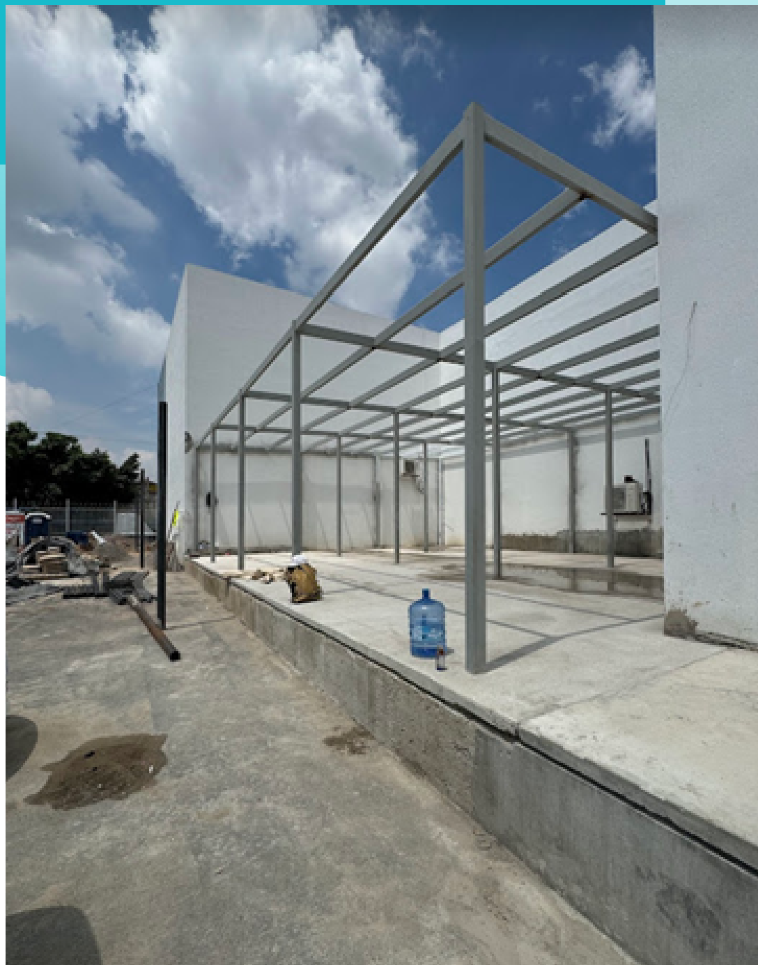
Adaptación de almacén en estacionamiento techado
