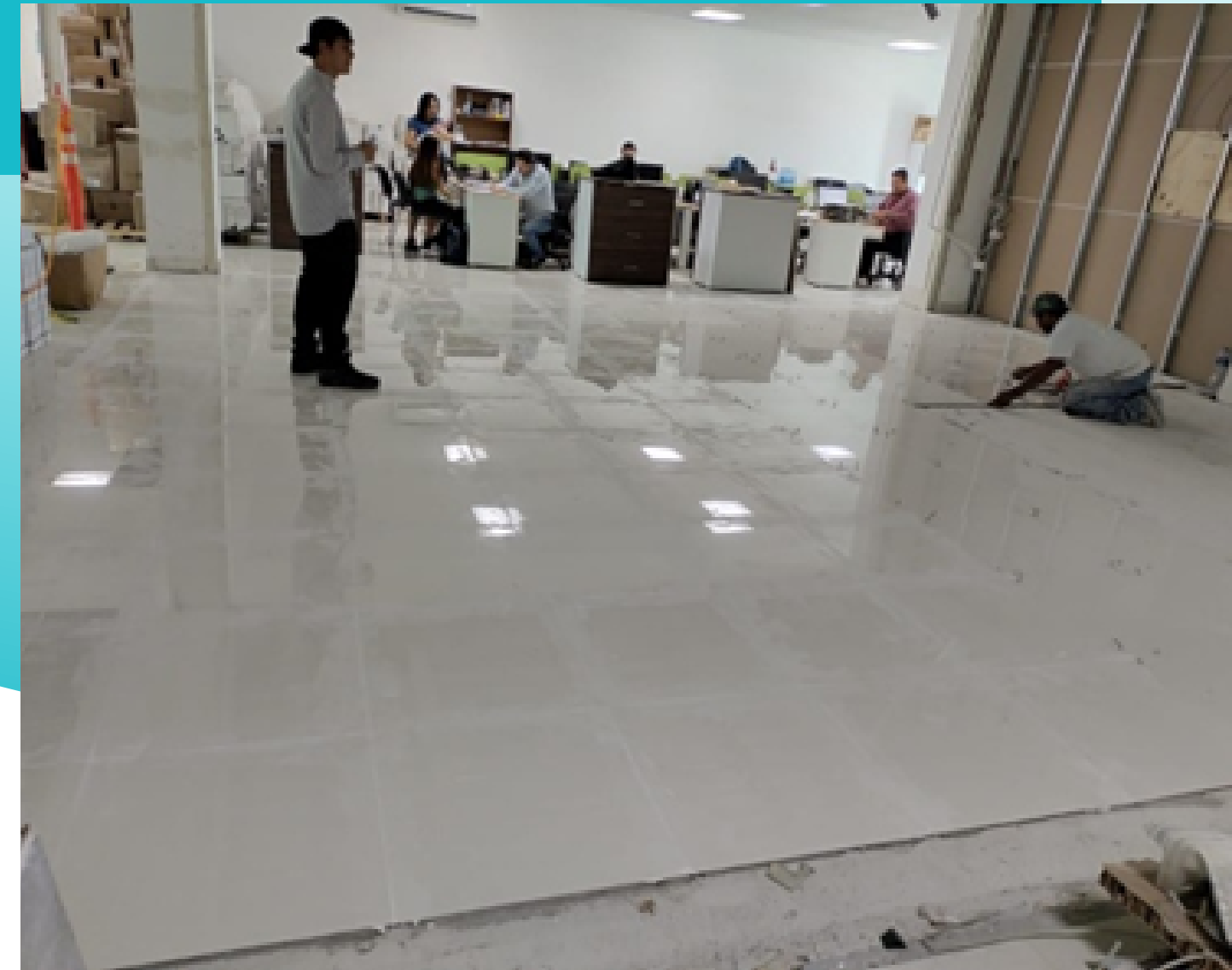
Construcción de oficinas complementarias para los servicios en cubo de luz
