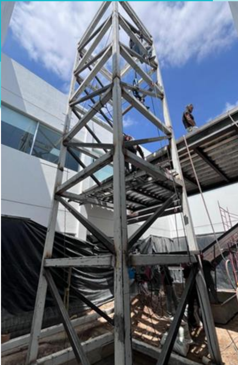
Construcción de cimentación y estructura para elevador panorámico Construcción de escaleras para intercomunicación entre planta baja y alta Andador de comunicación en planta alta de las dos áreas de consulta
